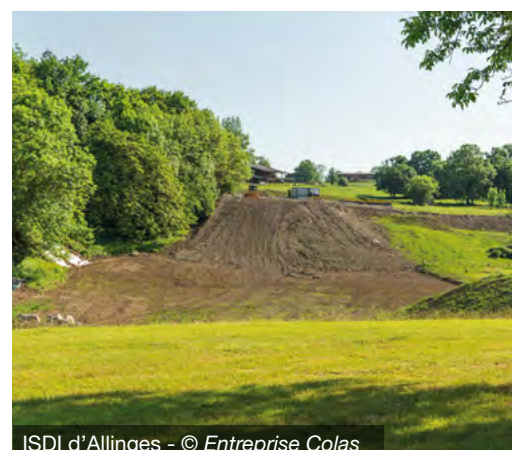
ISDI d'Allinges - © Entreprise Colas
